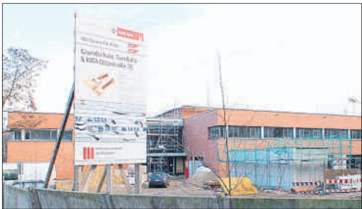
Mitte 2014 soll die Schule fertig und eingerichtet sein. (Foto: Brühl)
